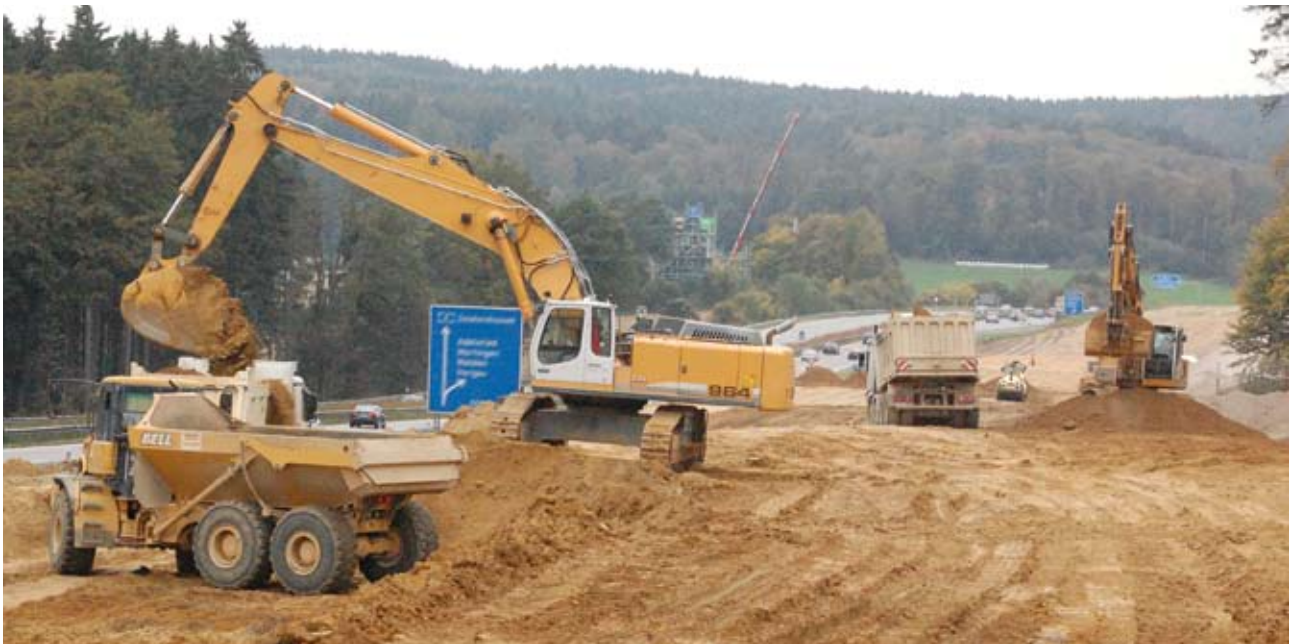
Der autonomieunterstützte Maschineneinsatz auf Baustellen ist Teil eines Forschungsprojekts
