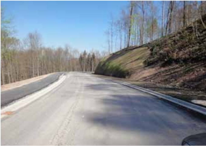
Neubau Regenüberlaufbecken Scheffoldstraße in Schwäbisch Gmünd
