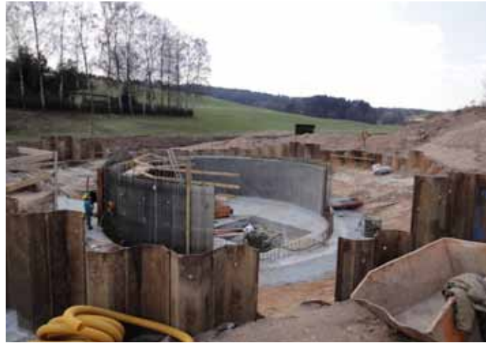
Neubau Regenüberlaufbecken in Gschwend
