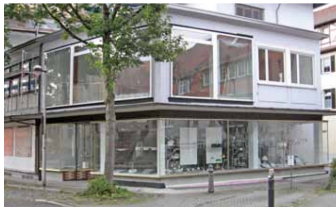
Aufgrund einer Vielzahl von Anschlussdetails und sehr kleinen Flächen waren die Aufgabe aufwendig und die Leistungsbeschreibung entsprechend komplex
