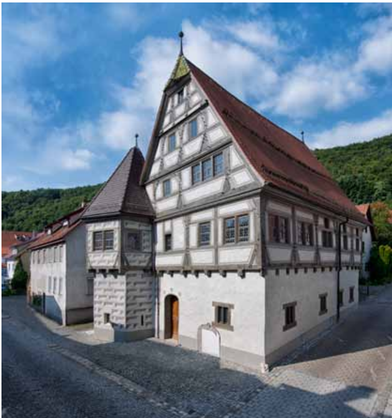
Das „Kleine Große Haus“ in Blaubeuren nach der Sanierung
