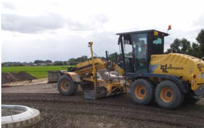
Einbau der Schottertragschicht mit Grader per GPS Maschinensteuerung
