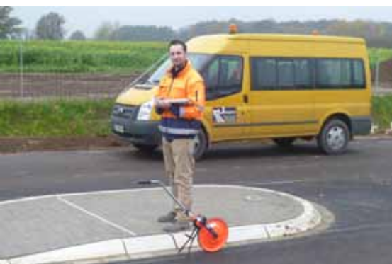
Bautechniker Thomas Farin bei der Erfassung der Mengen und Maße
