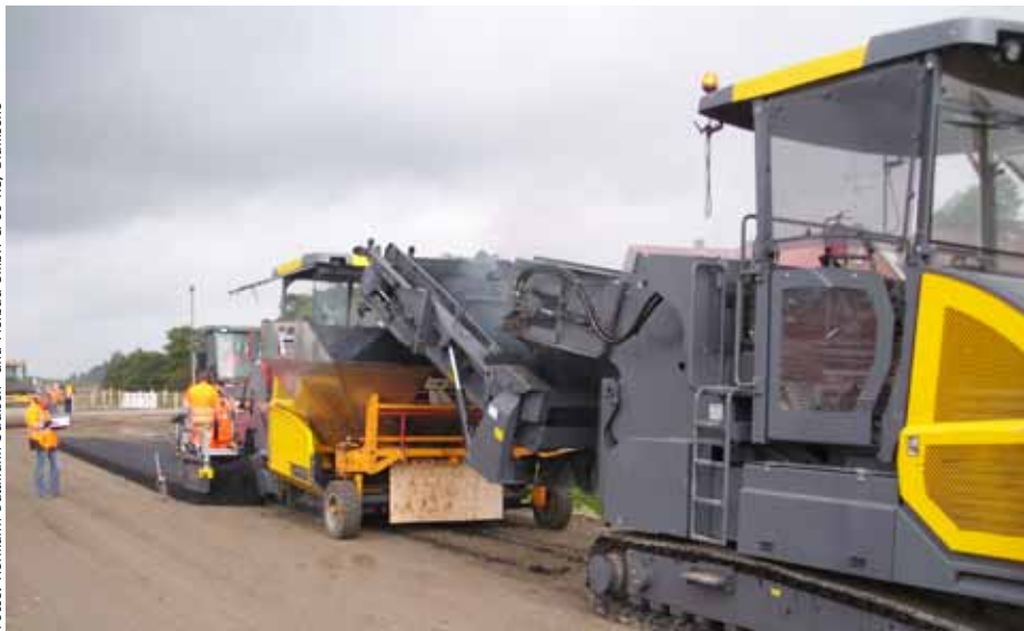
Einbau der Asphalttragschicht mit Fertiger und Beschicker
