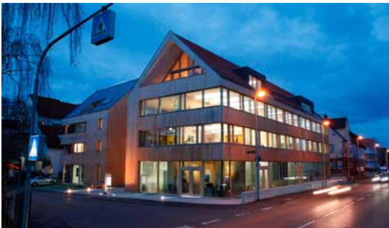
Wohn- und Geschäftshaus „Eisbärhaus“ – Fassade
