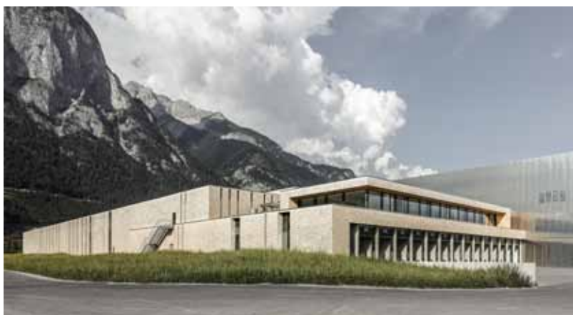
Aktuelles Bauprojekt von ATP: In einem Zeitraum von nur 13 Monaten entstand der Neubau eines Lebensmittelproduktionsgebäudes am Standort Völs nahe Innsbruck für die österreichische Supermarktkette MPREIS.
