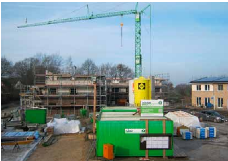
Neubau von zwei Mehrfamilienhäusern mit 38 Wohneinheiten und Tiefgarage in Reinbek
