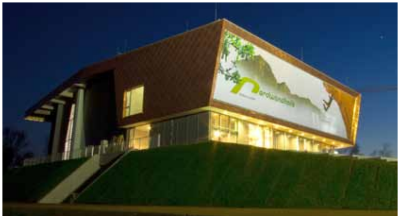
Bei der „Nordwandhalle“, einer Kletterhalle in Hamburg, war das Ingenieurbüro Többen für die Planung und Ausschreibung der Haustechnischen Anlagen zuständig.
