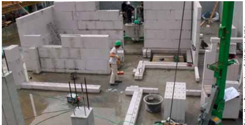
Neubau von 45 Wohneinheiten und Tiefgarage in Wedel
