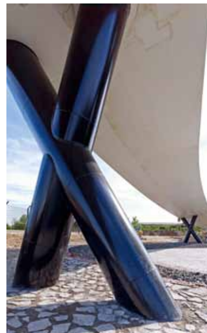
Ölhafenbrücke in Raunheim: Kosten, Leistungen und Termine – immer im Plan mit der Software (Objektplanung, Ingenieurbauwerk, Tragwerksplanung, Bauüberwachung)
