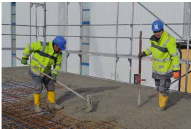
Fensterle-Mitarbeiter beim Betonieren einer Decke
