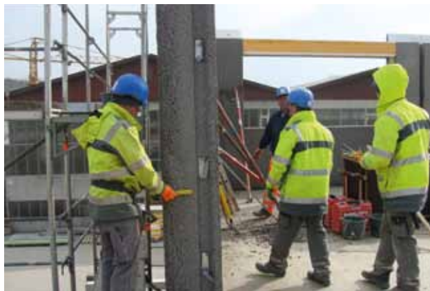
Versetzen von Blähtonfertigteilen beim Büroneubau von Fensterle
