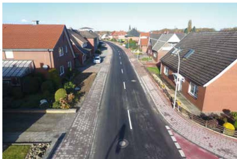
Befliegung des Bauvorhabens Straßen- und Kanalsanierung der Stadt Bersenbrück
