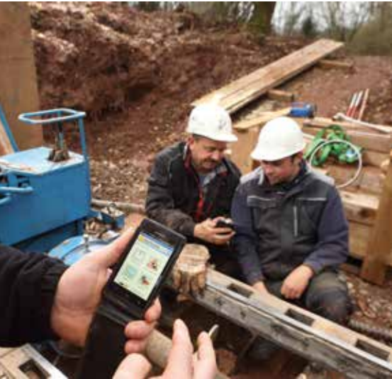
Fotos: AVE Asphalt-Vertrieb- und Einbau GmbH, Wendel
