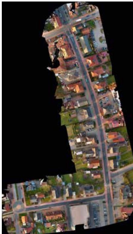
Befliegung des Bauvorhabens Straßen- und Kanalsanierung der Stadt Bersenbrück
